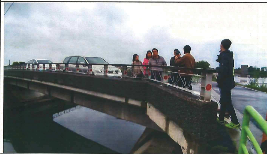
十六份排水現勘照片
