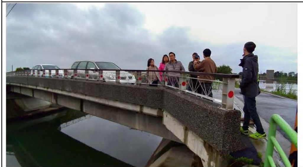
十六份排水現勘照片
