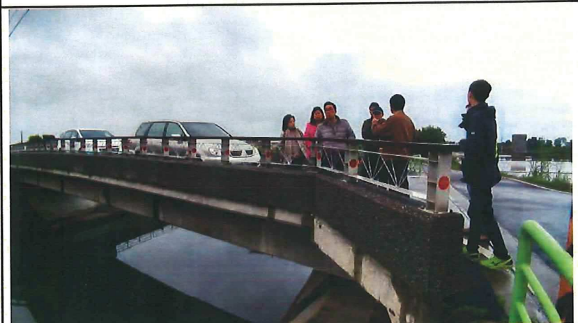
十六份排水現勘照片
