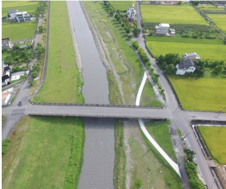
圖 6、已完成的尾塹橋自行車道立體交叉車道空拍照
