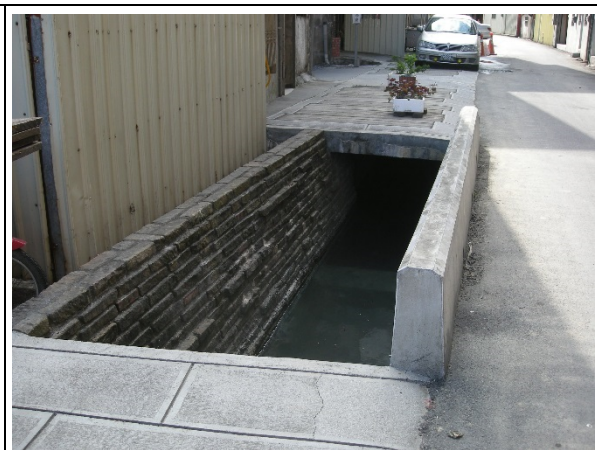
完工後-護岸修護，環境整潔
