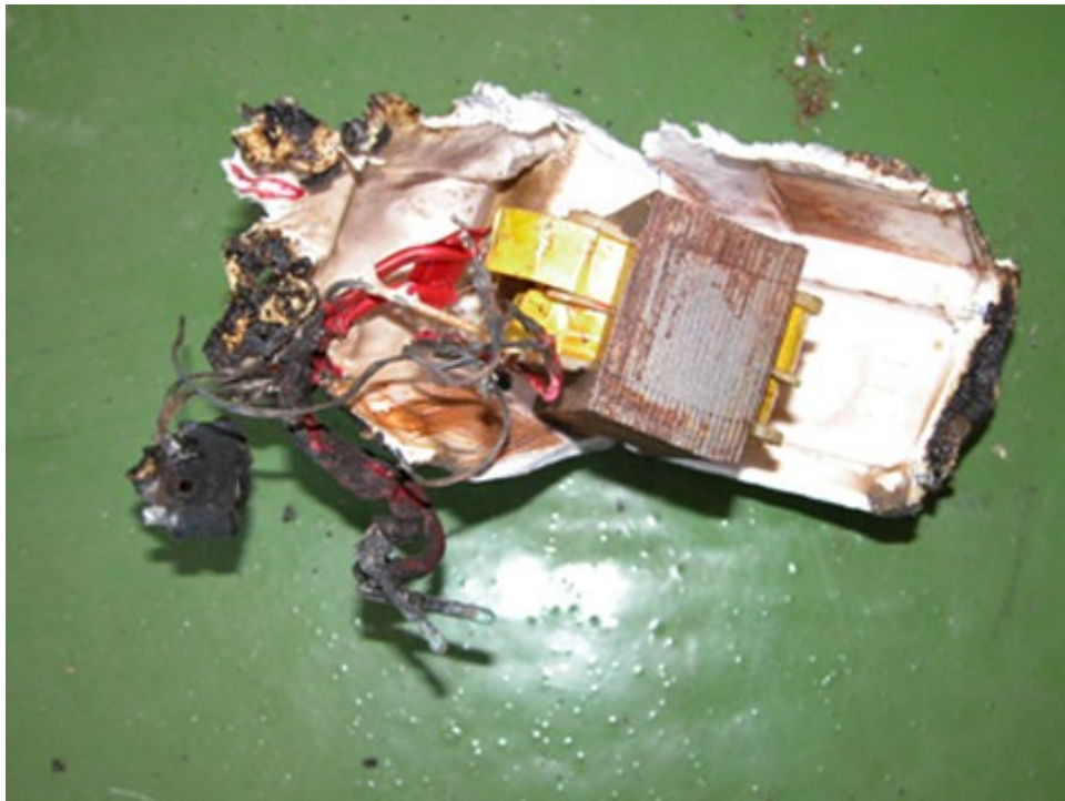
圖 6：排水器變壓器未受燒。
