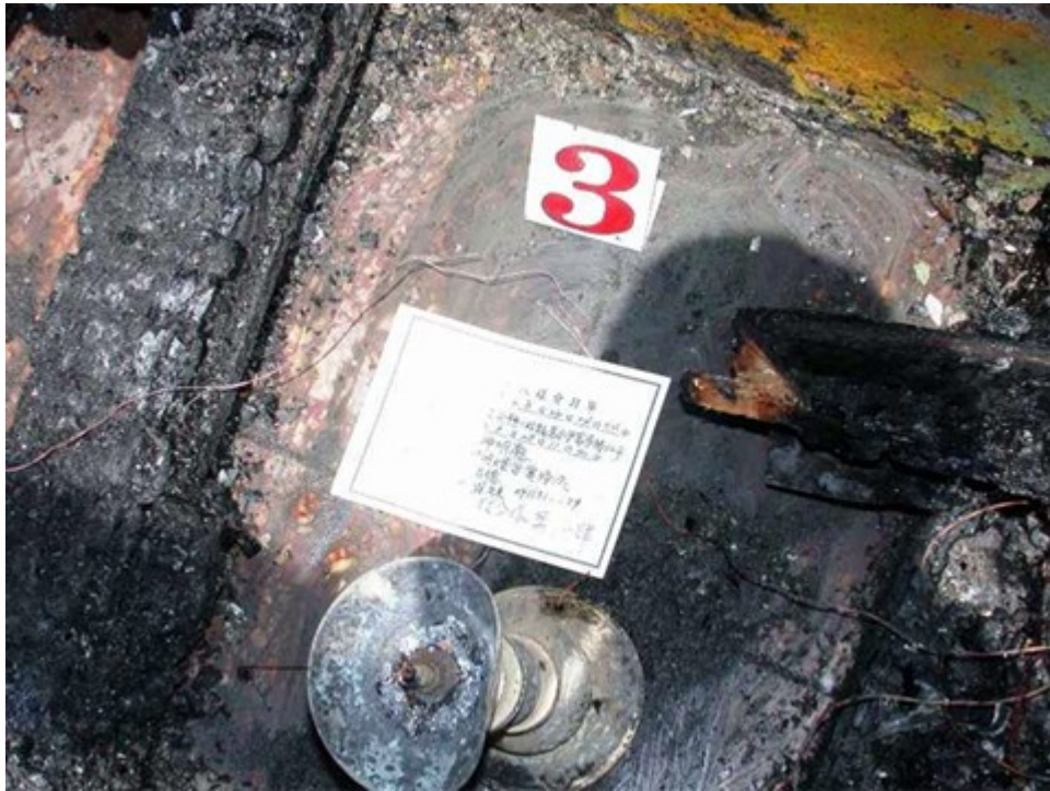
圖 5：勘查神明燈電源線嚴重燒熔燒斷。
