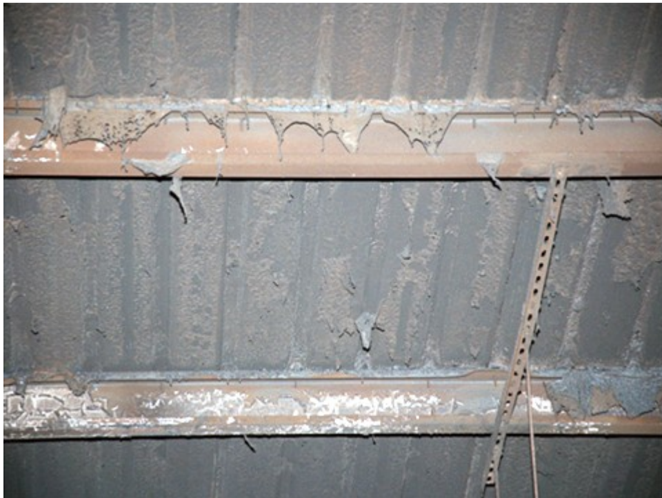
圖 3. 屋頂鐵皮有 PU 泡棉
