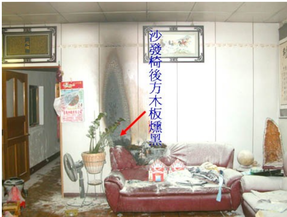
圖 1：客廳沙發椅後方木板牆燻黑。
