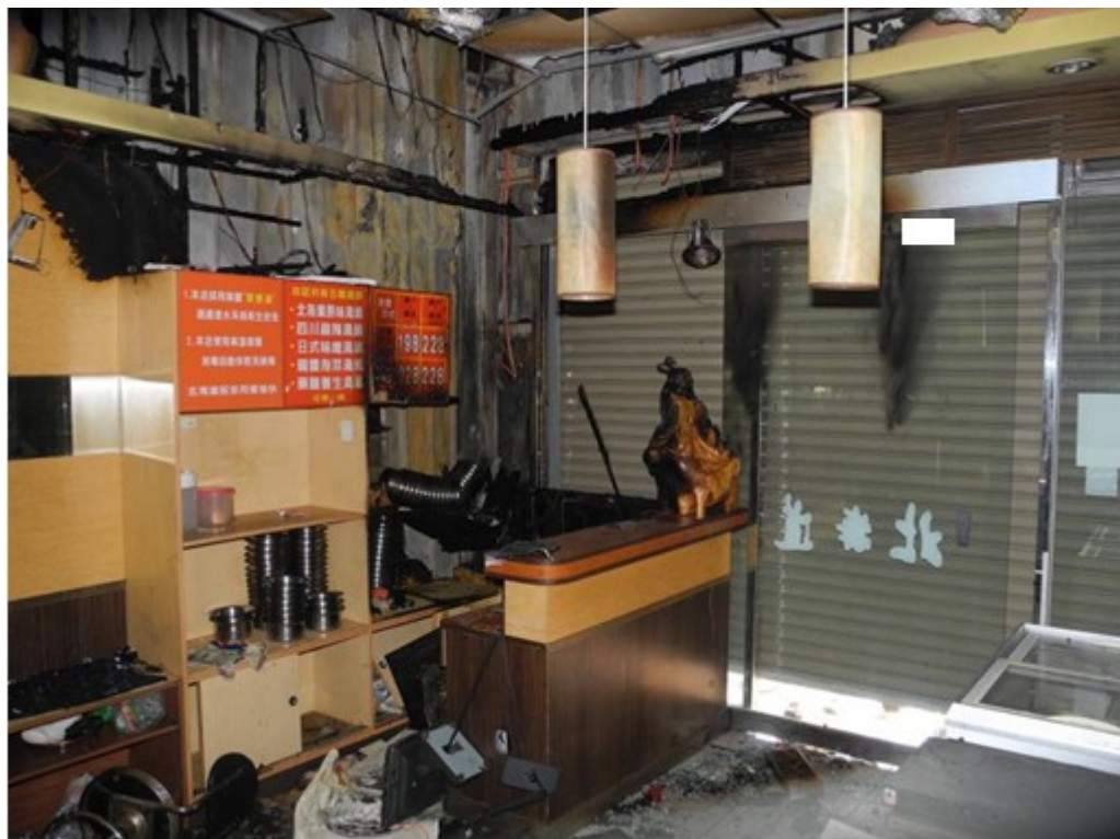
圖 1：1 樓用餐區西南側櫃台、裝簍、點餐機及監視設備燒損
