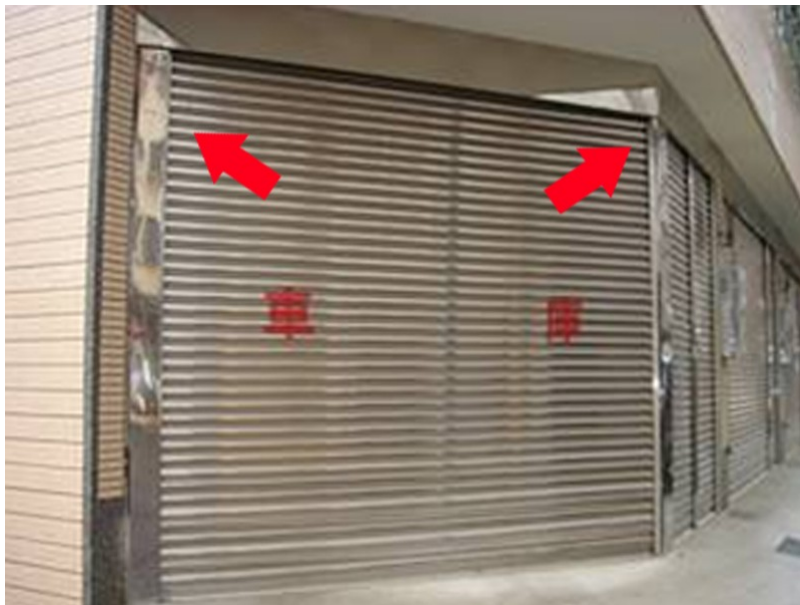
圖 5：鐵捲門兩側滑軌上方（紅色箭頭處）以固定鉗夾牢，則能有效制止捲門之滑落
