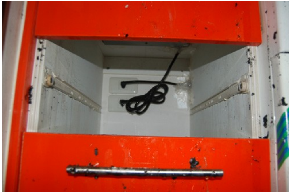
圖 4. 勘查電陶爐之電源線有接續於下方櫥櫃內之電源插座。
