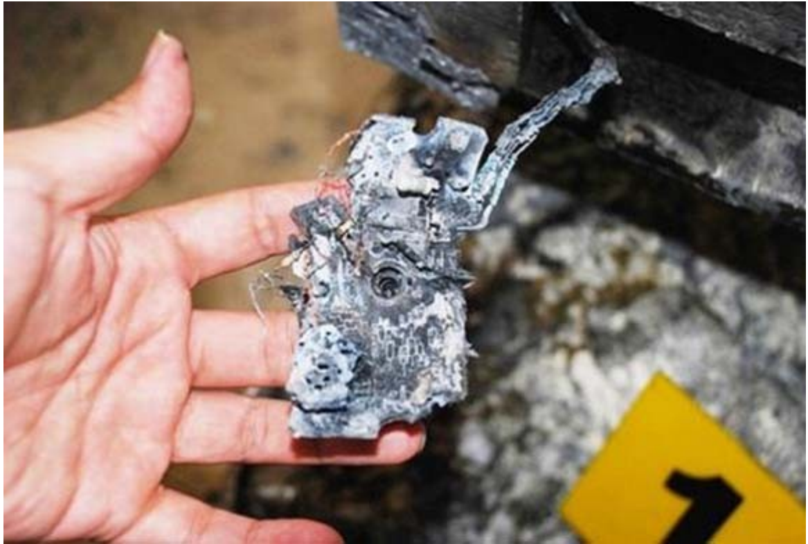
圖 4：C5 餐桌西側電磁爐開關，面板零件受燒情形較為輕微，電源線未發現斷裂通電短路痕跡。
