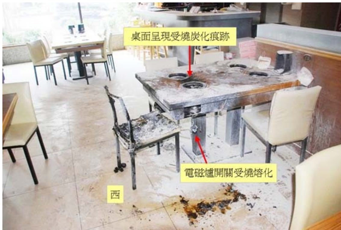
圖3：C5 餐桌位於西側擺放電磁爐桌面呈現受燒、炭化痕跡，西側桌面裝設電磁爐開關受火勢燒損熔化跡象，下方擺方座椅上方處受燒較為嚴重。
