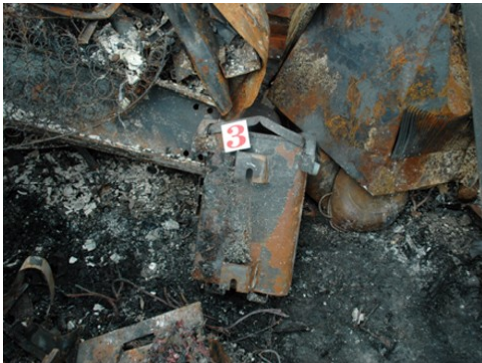
圖 2：變壓器上蓋遭壓力力量破壞。
