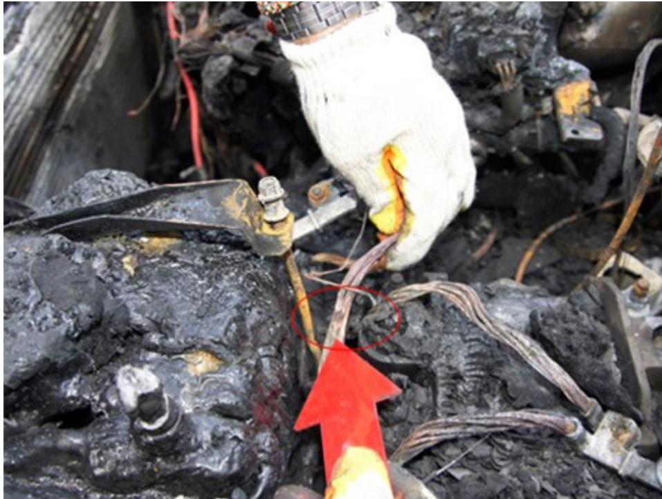
圖 1：電瓶正極電源線橫跨車體往保險絲盒之電源線，電源線被覆受燒毀並有搭鐵短路情形。
