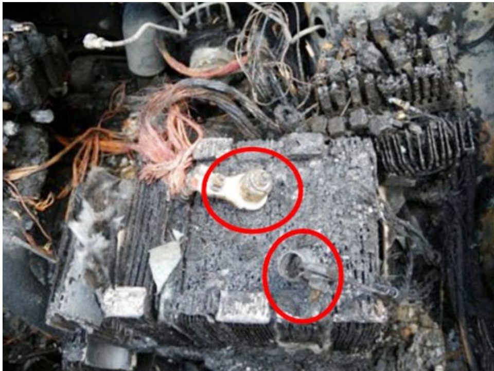
圖 6：電池正極樁頭未受燒（掉落電池旁），負極樁頭燻黑嚴重。
