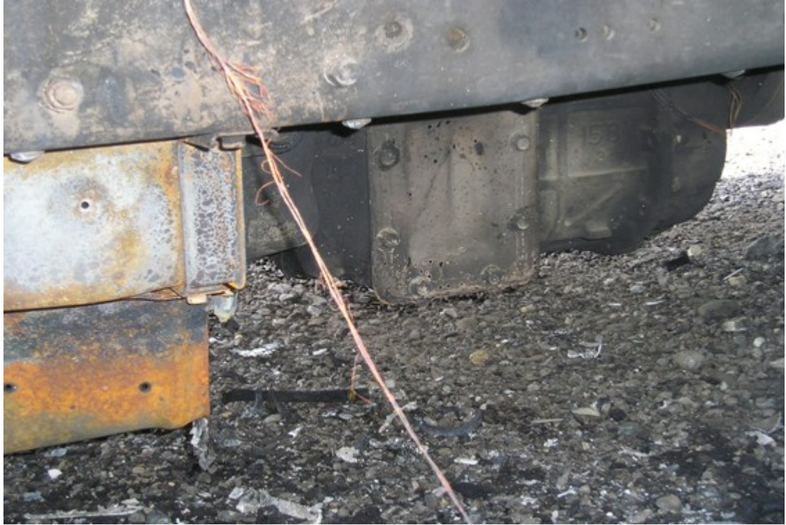
圖 8 頭引擎室連接後貨櫃部分有電線半斷線
