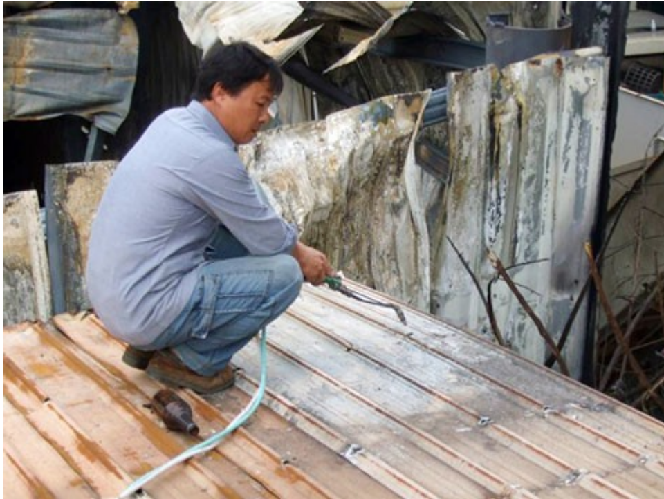
圖 5：重建現場切割工人作業位置
