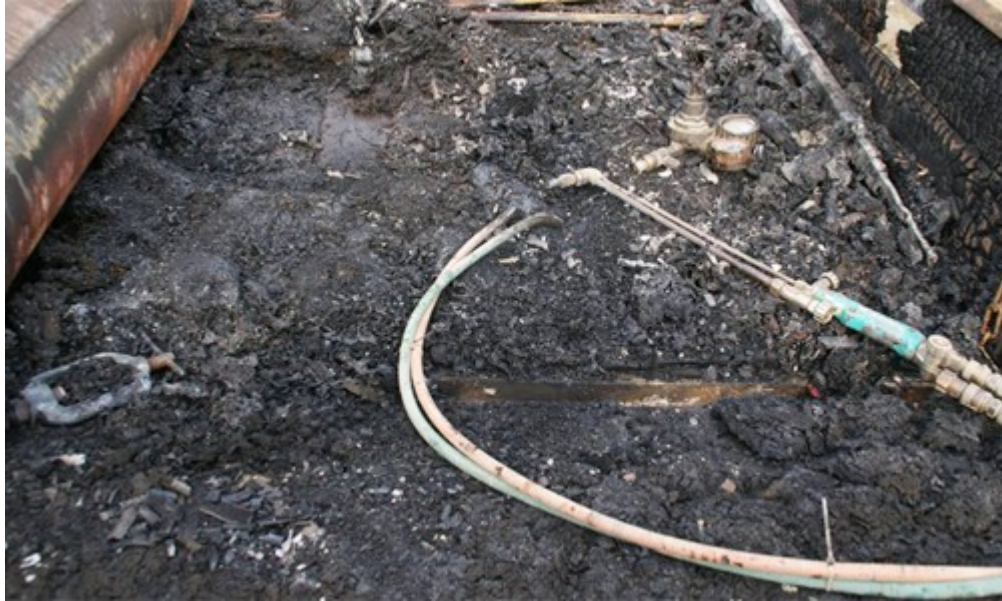
圖 2 檢視貨床後端受燒情形，發現兩只受燒鋼瓶（乙炔、氧氣）及一組受燒毀乙炔切割器及部分殘留橡膠延伸管
