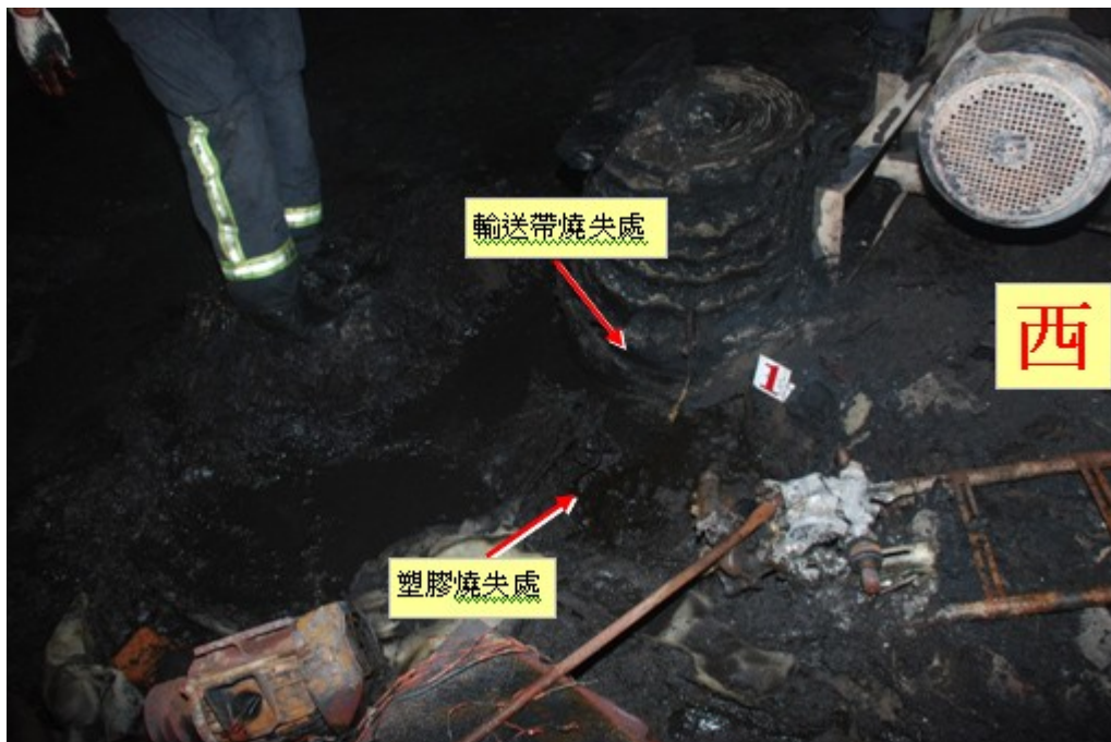
圖4：挖掘清除受燒嚴重處，發現地面塑膠以靠瓦斯噴火器垂掛位置（標示1）有燒失情形，且廢棄廢棄輸送帶捲以下方燒失情形較上方嚴重。
