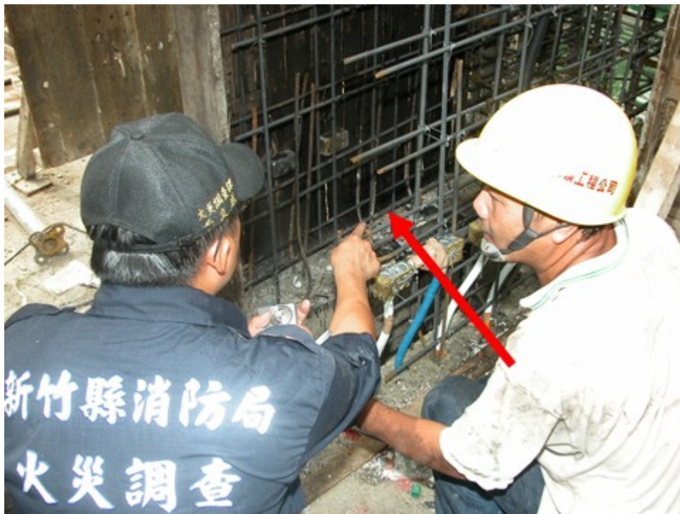
圖 1：工人切割鋼筋位置。
