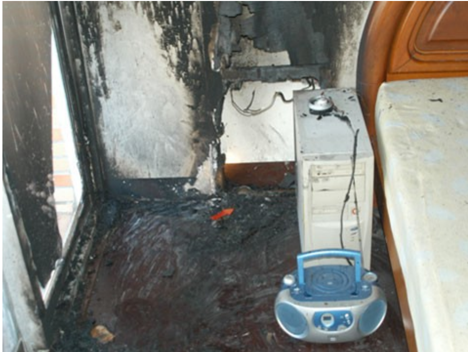
圖 1：床鋪旁裝潢牆面燒失。
