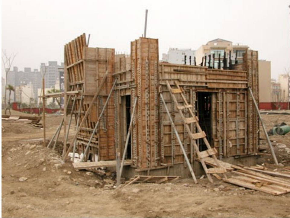
圖 5：新建中廁所屋頂受燒。
