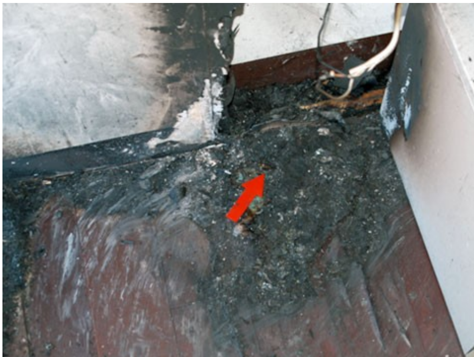
圖 2：電腦後側方燻黑，垃圾桶燒熔。
