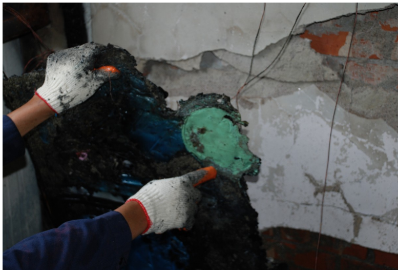
照片 2：起火戶房間 3 東南側塑膠垃圾桶底呈現由上而下燒穿痕跡。
