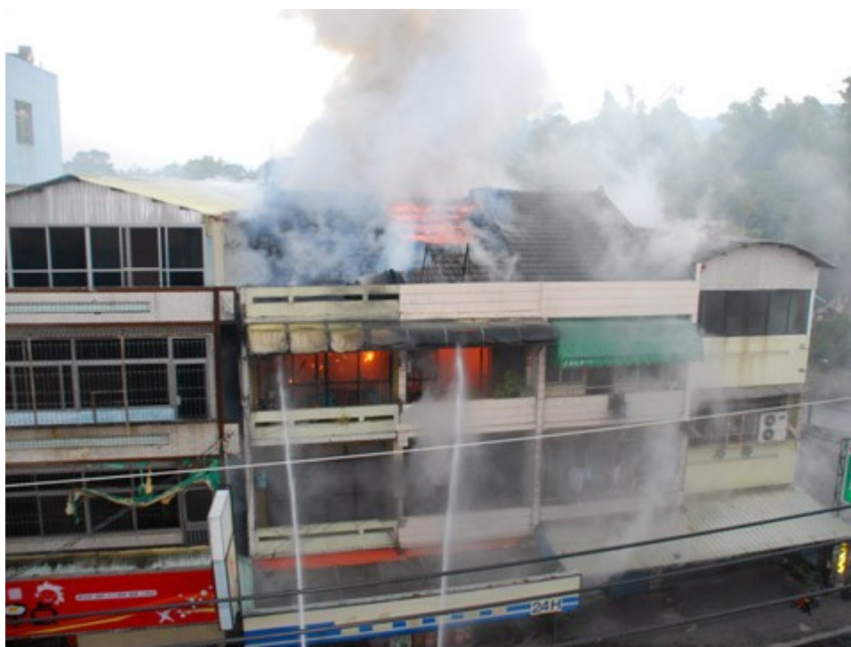
【圖1 現場燃燒狀況】
