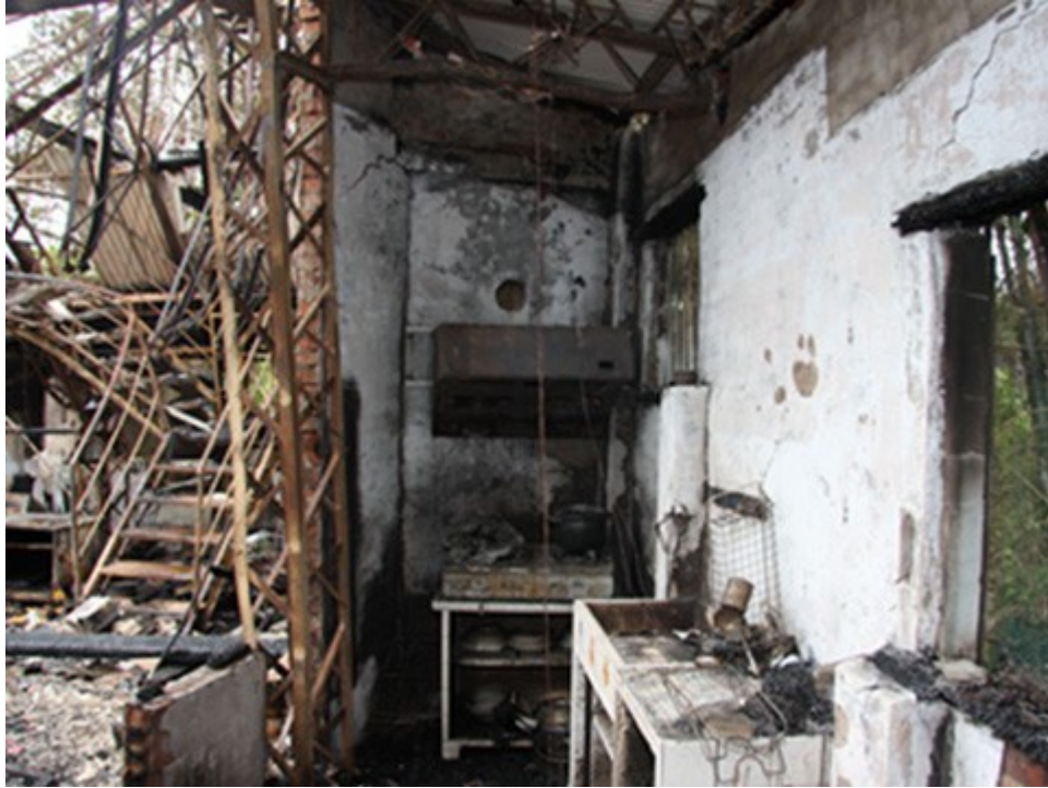
圖 1：災後起火戶 1 樓東側廚房瓦斯爐具附近燒損碳化最為嚴重。
