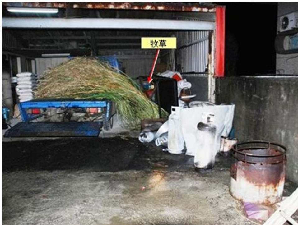
圖 2. 倉庫旁瓦斯爐及瓦斯鋼瓶受火勢劇烈燒損
