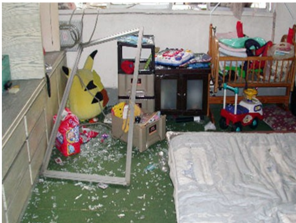
圖 3：現場 2 樓臥房內鋁門窗玻璃受氣爆被震碎情形
