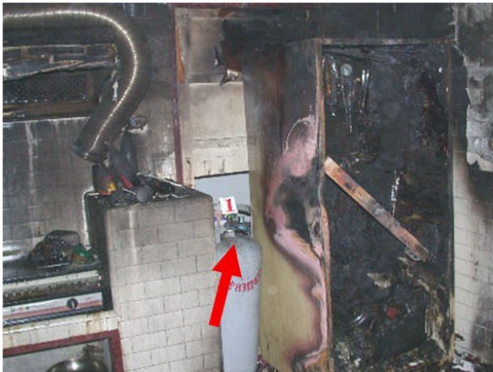
圖 5：北側面板產生 V 型火流情形
