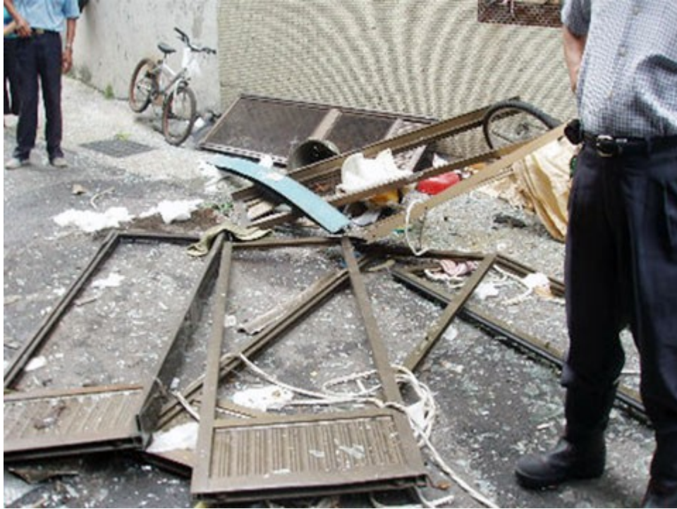
圖 1：現場 1 樓鋁門受氣爆炸開彈至地面情形
