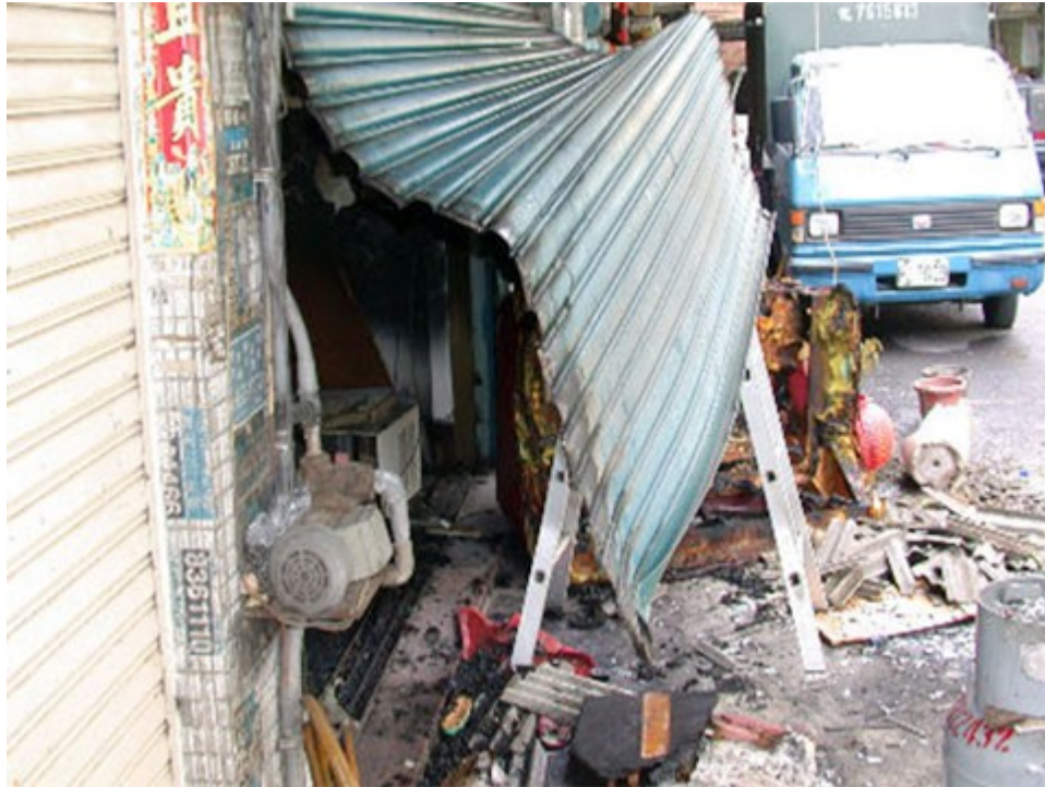
圖 2：現場 1 樓鐵捲門受氣爆炸開情形
