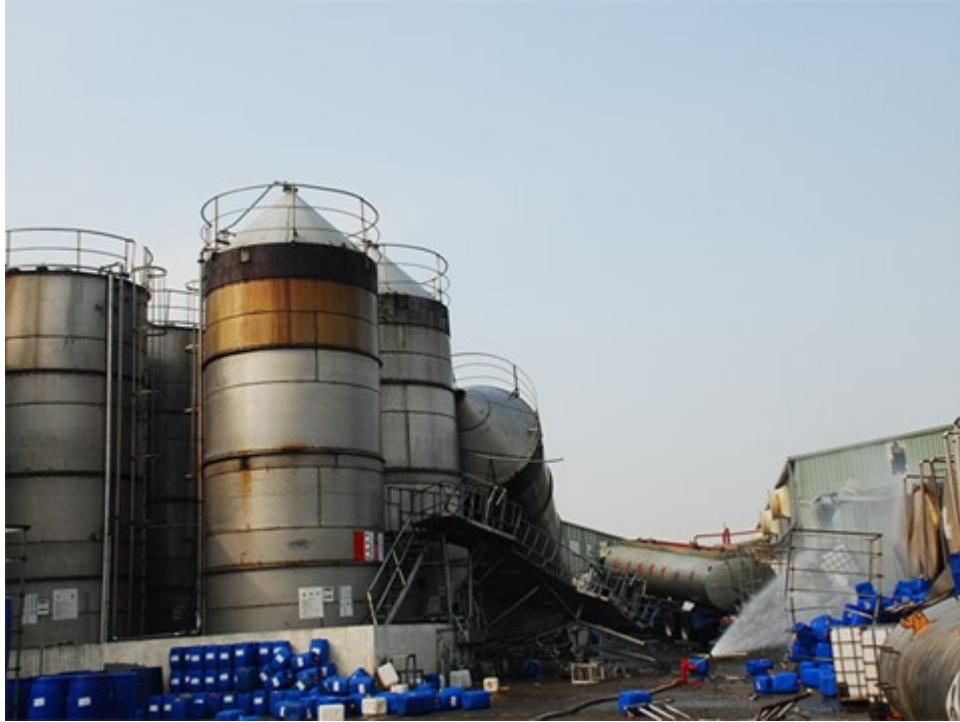
圖 1. 現場位於室外儲槽區
