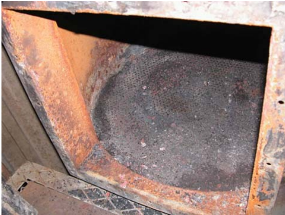
圖 5：活性炭置入孔開啟後鐵網受燒情形。
