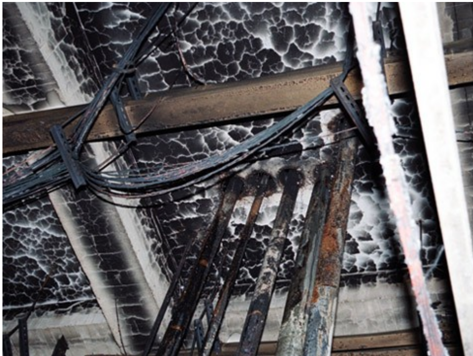
圖 6. 2 樓水經樓地板孔洞向下（1 樓）流
