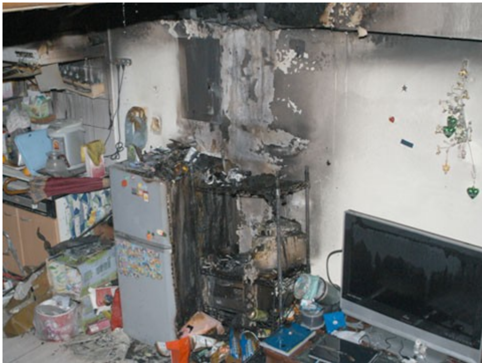
圖 2：起火戶東側，冰箱南側受燒嚴重。
