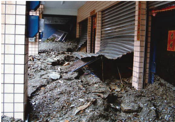
【圖 2-1-9】梅姬颱風造成之土石坍塌（鄭俊彥提供）
