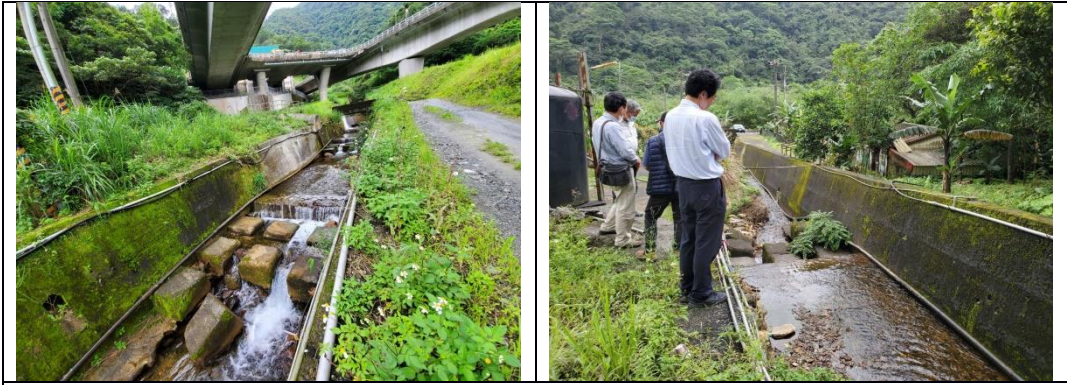
蘇澳鎮永樂社區蘇花改公路湧泉水環境改善工程計畫現勘
