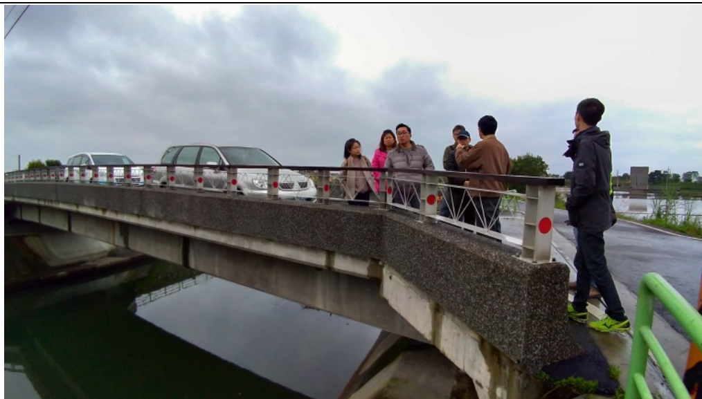
十六份排水現勘照片
