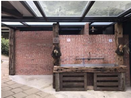
圖 1 體驗環境建設-廁所
