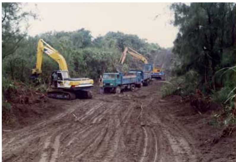
↑ 怪手開挖進入防風林道路
