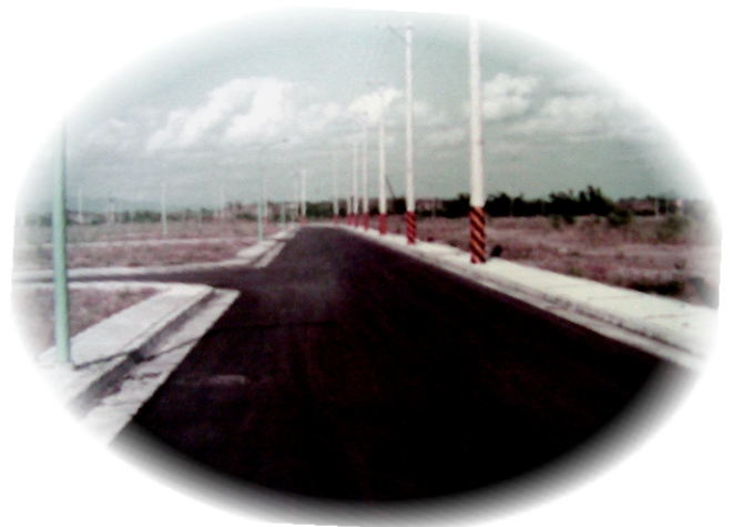
↓ 新社區道路建設 鎮公所提供
