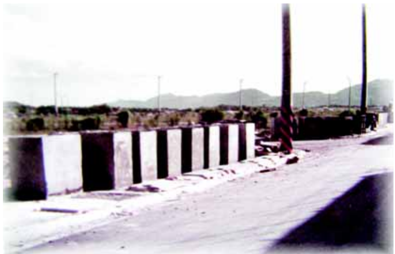
↓ 新社區公共建設 鎮公所提供
