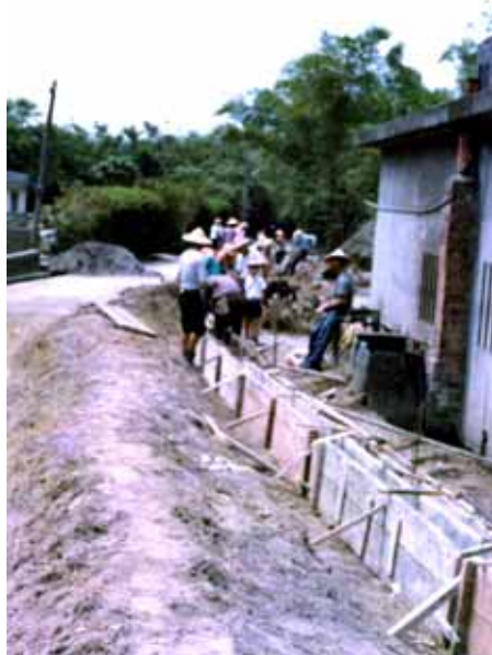
↓ 公工修建排水溝 張金純提供
