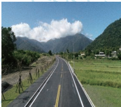
蘇澳鎮南強橋銜接 宜56線道路新建工程
