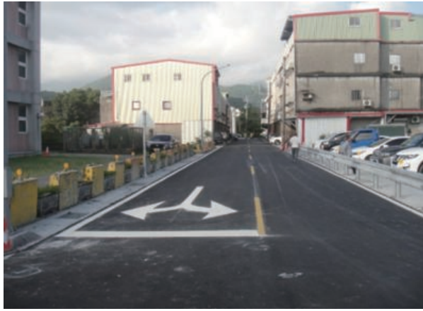
蘇澳鎮新馬地區 第91號道路開闢工程
