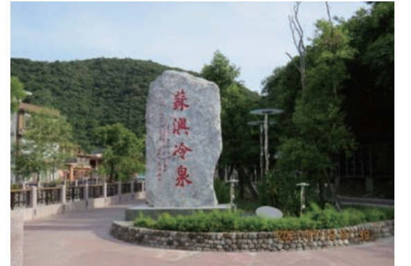
蘇澳冷泉大眾池 設施改善工程
