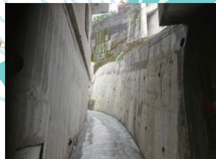
蘇澳鎮南興路擋土牆改善工程
