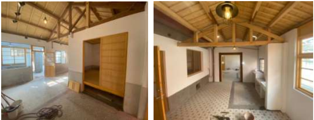
19 號室內現況照片
