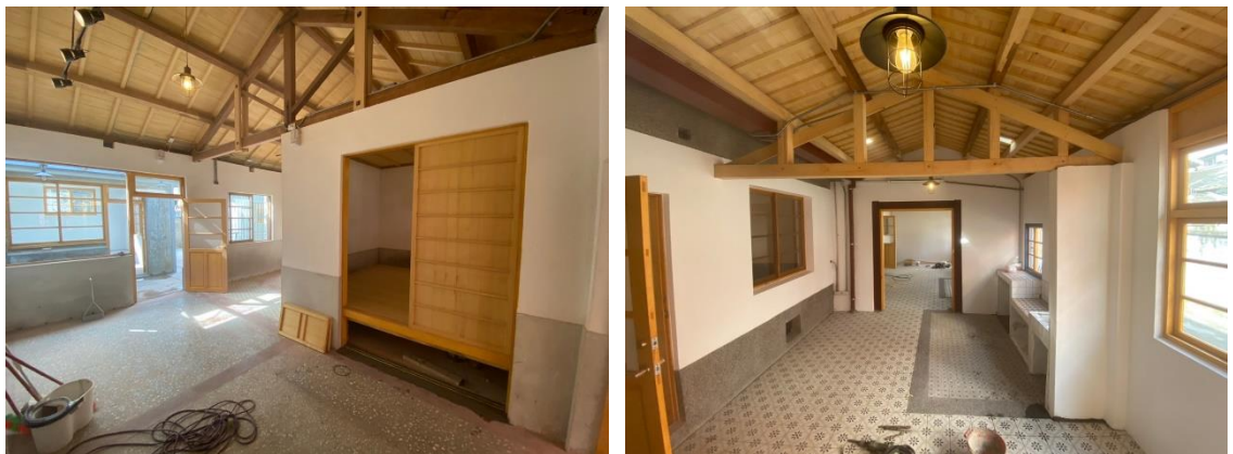
照片 10 19 號室內現況照片
