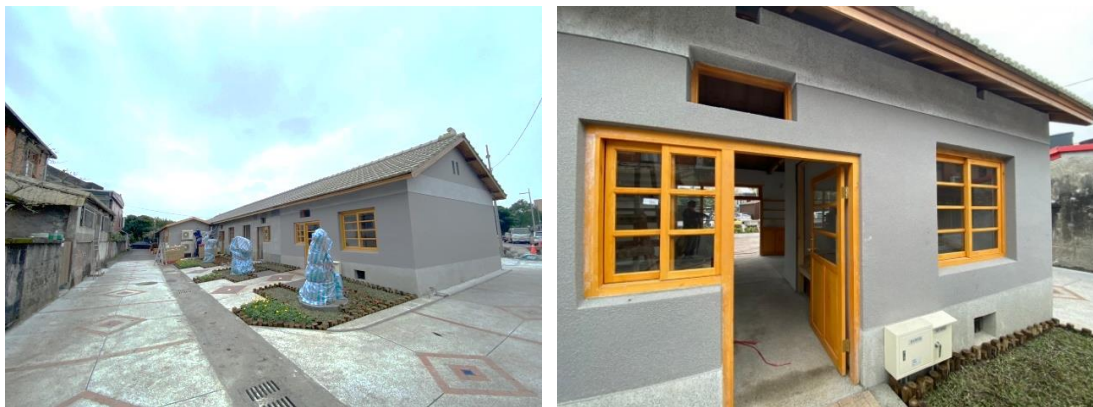
照片 6 11 號 (13、15 號同) 戶外現況照片
