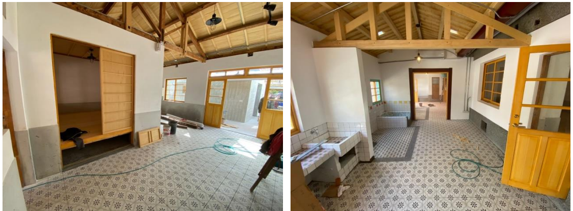
照片 9 17 號室內現況照片
