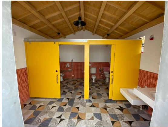
照片 11 園區廁所現況照片
