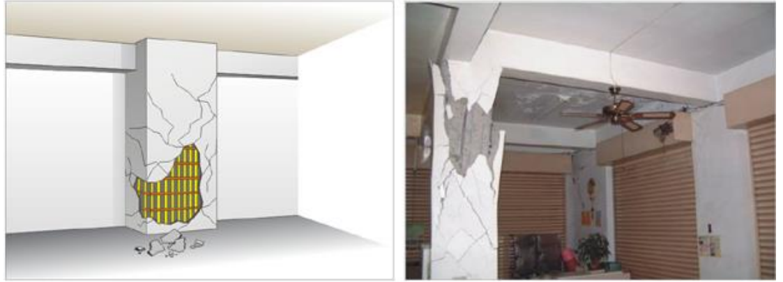
圖 2-11：鋼筋外露示意圖與照片 26
