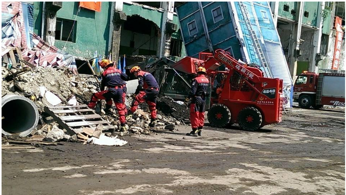
圖 2-1：震後建築物易造成倒塌(2015.4.15 民安演習)
