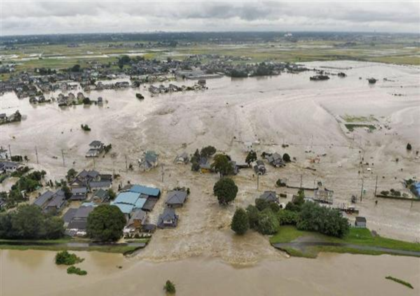
鬼怒川堤防決壊(平成27年9月関東・東北豪雨 2015.9.11)
