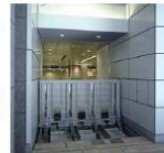
①ビルの出入口(ロビー)からの浸水を防ぐ防淹板(写真提供:三菱地所)
