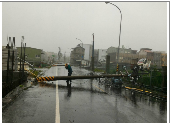
五結鄉電桿倒斷情形
