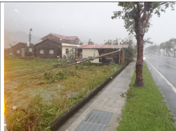
三星鄉電桿倒斷情形
