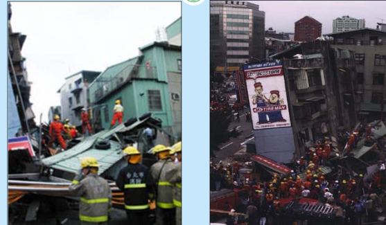
承德路一棟公寓大樓倒塌，屋內8人受困，經過數小時搶救，八人均平安脫困
