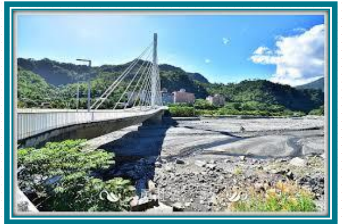
拆除舊橋興建新橋
