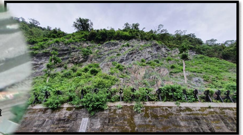
194縣道邊坡改善
