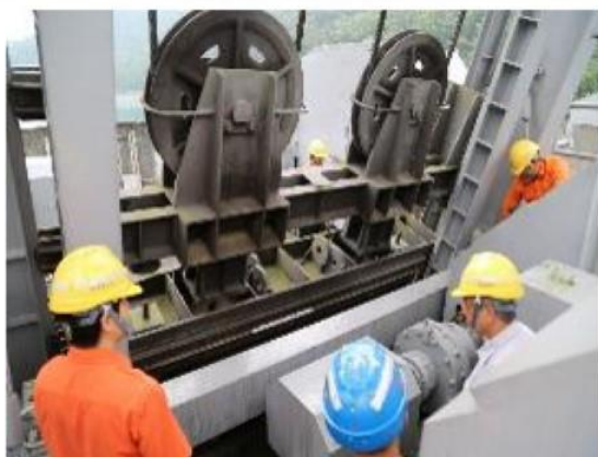
▲ 沖刷道擋水閘門檢查與測試
