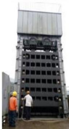
▲ 沖刷道擋水閘門檢查與測試
