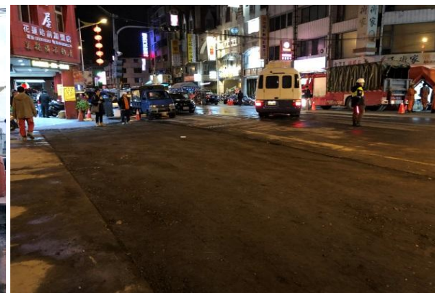
商校街/進豐街修復完成情形
