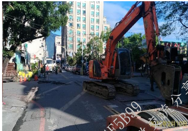
以機具大面積破碎並重新鋪設路面
