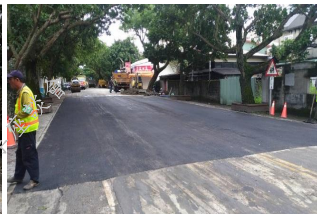
明禮路修復完成情形
