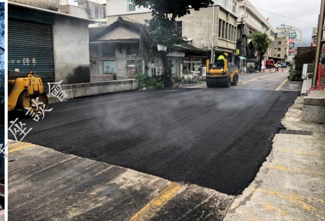
三民街修復完成情形
