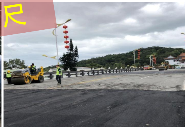
尚志橋修復完成情形
