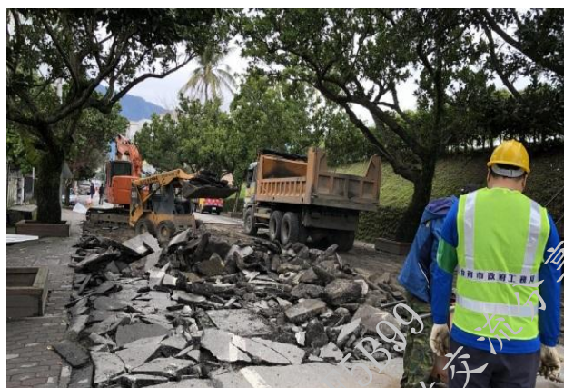
以機具大面積破碎並重新鋪設路面
