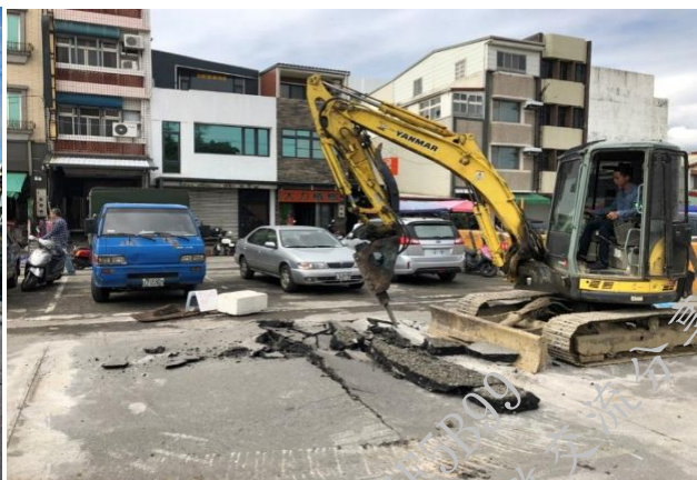
以機具大面積破碎並重新鋪設路面
