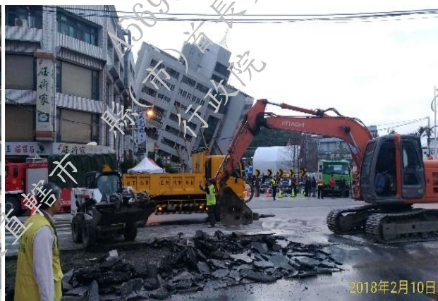
以機具破碎路面並重新鋪設
