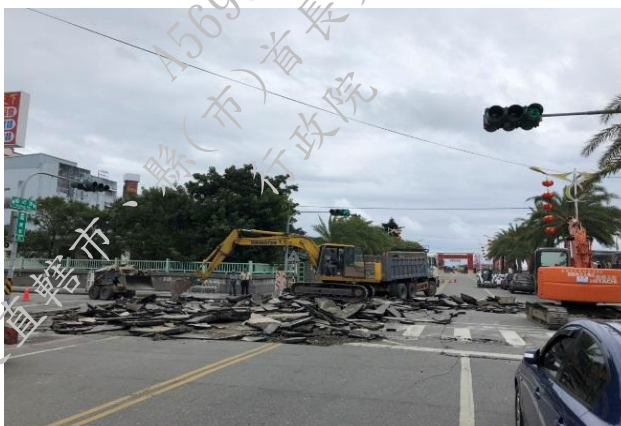
以機具大面積破碎並重新鋪設路面
