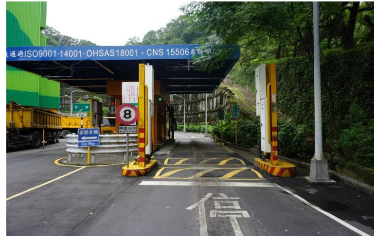
垃圾焚化廠之門框式輻射偵檢器
